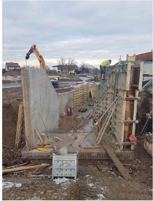
Abb. 5: Die Schalung des Schnecken-troges erfolgte im trockenen Winter 2018/2019.
