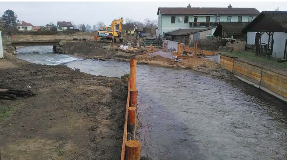
Abb. 3: Umleitung des Kehrbaches in der Bauzeit
