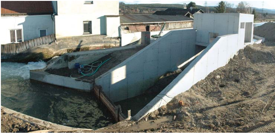
Abb. 6: Fertigstellung des Rohbaues und Abdichtung Unterwasser
