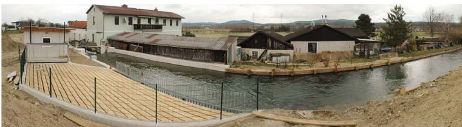
Abb. 13: Die fertige Anlage vom Oberwasser her gesehen
