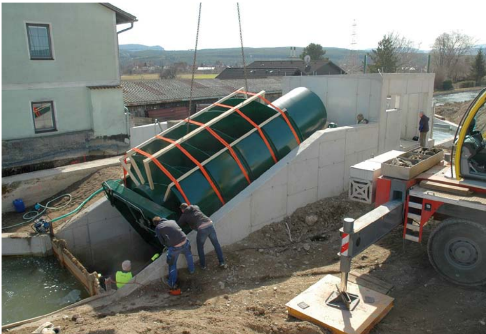
Abb. 9: Einrichten der Wasserkraftschnecke mit dem Schwerlastkran
