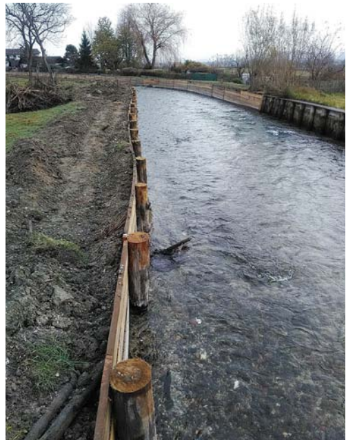
Abb. 2: Uferwände neu und alt nebeneinander Abb. 1–3: Ingenieurbüro Lashofer
