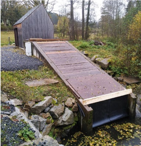
Abb. 7a: Schallschutz außen
