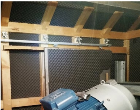
Abb. 7b: Schallschutz innen Fotos: Ingenieurbüro Lashofer
