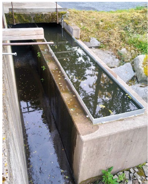
Abb. 6c: „Entenschnabel“ mit Erhöhung Fotos: Ingenieurbüro Lashofer
